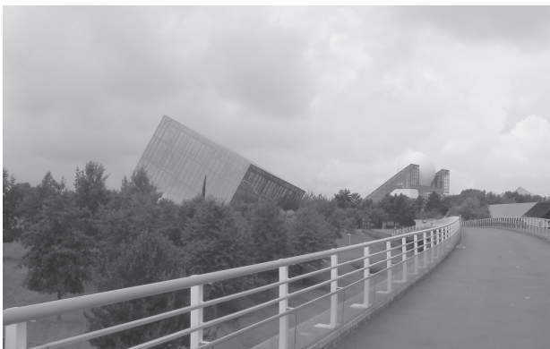
図6. TGV駅からパーク内への陸橋
